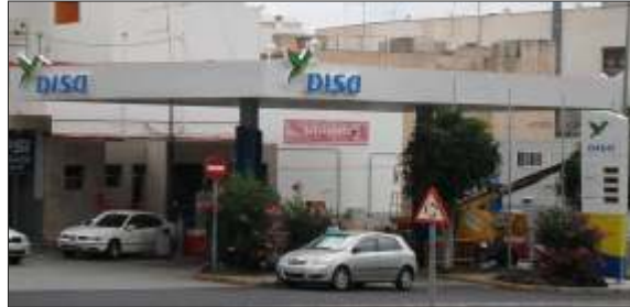
Se inician las obras en la Estación de Servicio de Vegueta
